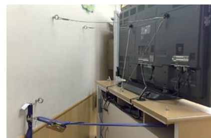
タッチディスプレイは壁とディスプレイスタンドの両方に繋がれている。ディスプレイスタンドもフックで繋がれており、十分な転倒防止策が施されている。
